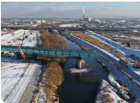
[2019年11月] 送出し工法による架設の様子
