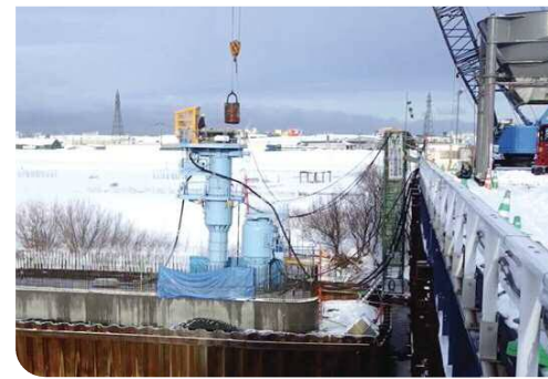
【2015年1月】ニューマチックケーソン工法による排土作業の様子
