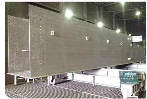
【2019年7月】細幅箱桁の製作の様子
