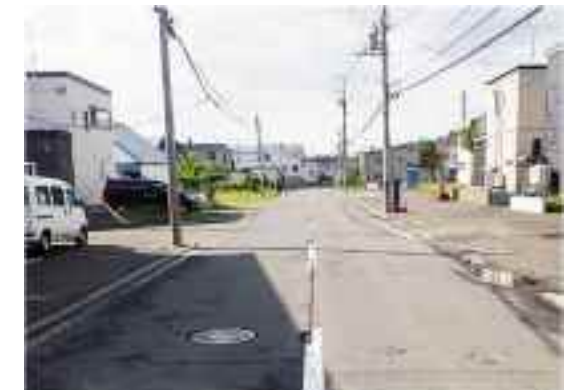
整備前の道路の状況 (R4撮影)
