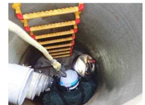
最下段 止水パッカー除去
