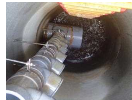
最下段 止水パッカー除去前
