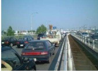
整備前(環状北大橋 渋滞状況)
