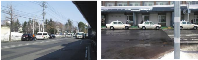
事業区間(整備前)
