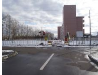
事業区間(整備前JR北側)
