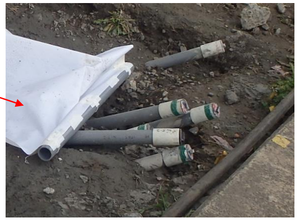
注入完了後に管を閉塞し、地表面近くの管は地中で切断し撤去を行う
