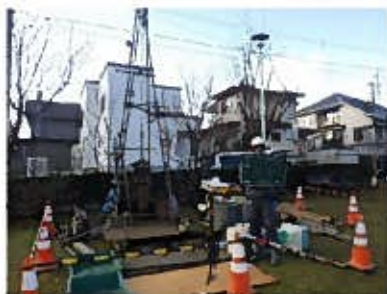
写真-ボーリング実施状況
