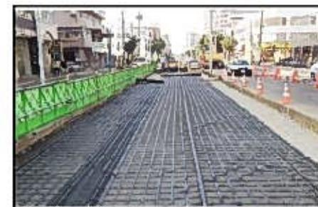
不等沈下による被害を軽減するため、碎石を厚くし、変形を抑制するシートを敷設する等
