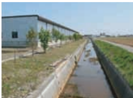
■コンクリート三面張りの川 (丘珠5号川:東区) 流れが一様で、横断的な変化が無い
