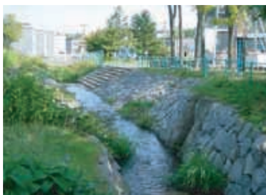
■公園と一体となった整備の水辺に近づく階段
