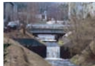
■中の川の改修前の落差工
