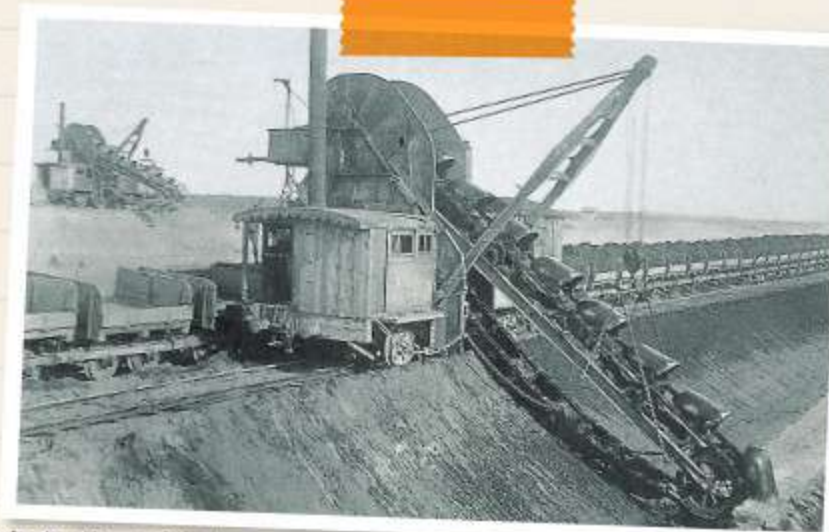
新水路掘削(くっさく)作業の様子(「石狩川流域発展の礎・治水」より)
