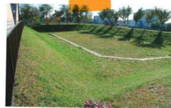
雨水貯留池(白石区)
