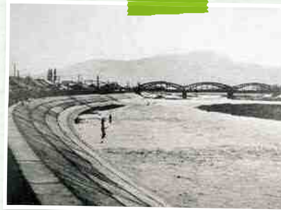
工事が完了した豊平川の護岸(「石狩川流域発展の礎・治水」より)
