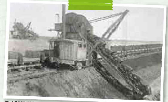
新水路掘削(くっさく)作業の様子(「石狩川流域発展の礎・治水」より)
