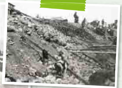
護岸工事中の豊平川 (「石狩川流域発展の礎・治水」より)
