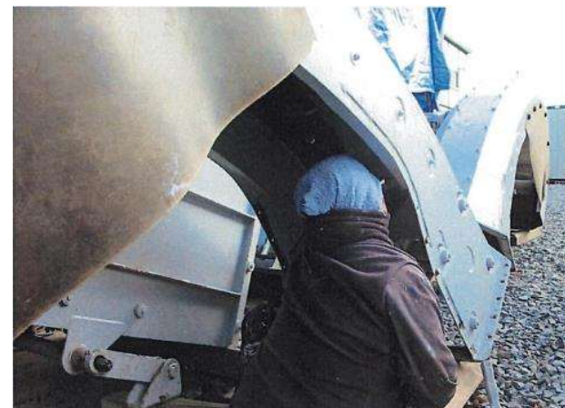
ロータリー排雪シュート部塗装作業状況①
