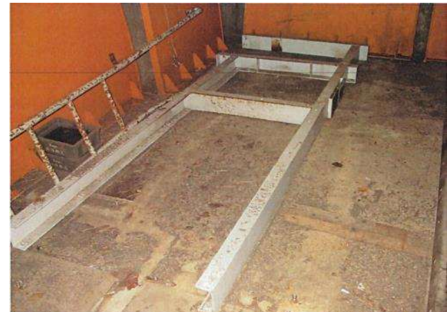
ロータリー走行装置カバーフレーム塗装前状況
