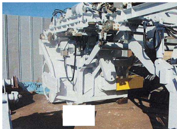
ロータリー補修塗装完了状況①
