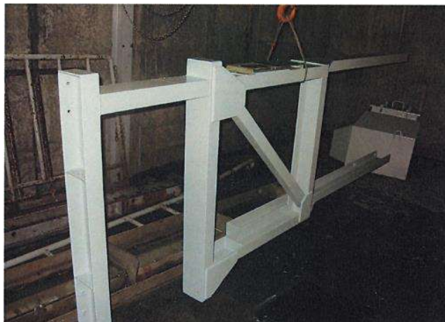
ロータリー補修塗装完了状況⑨
