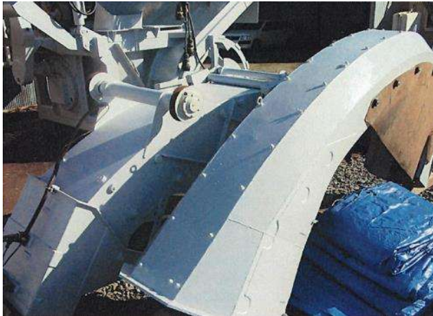
ロータリ―補修塗装完了状況⑦
