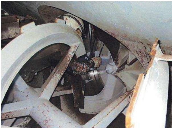
ロータリーオーガー・ブローア部塗装前状況②
