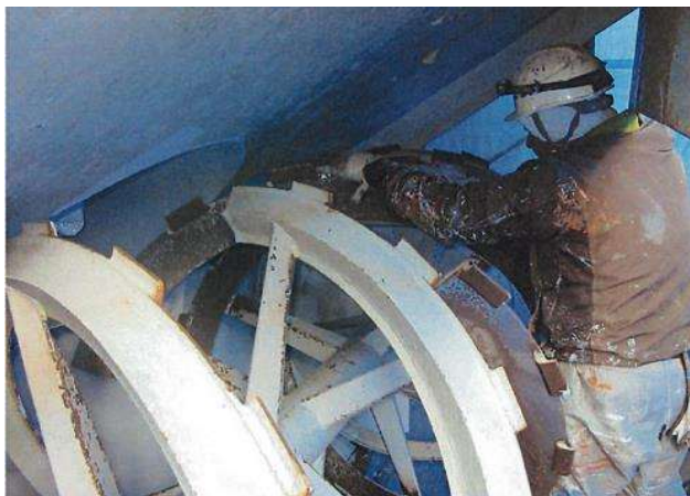
ロータリーオーガー部塗装作業状況
