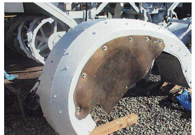
ロータリ―補修塗装完了状況⑧
