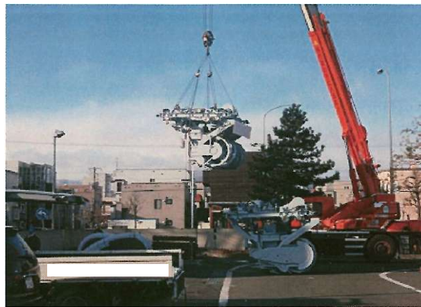
ロータリー搬入状況②
