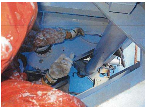
ロータリー本体部塗装作業状況
