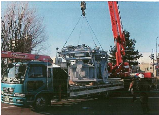
ロータリー搬入状況①
