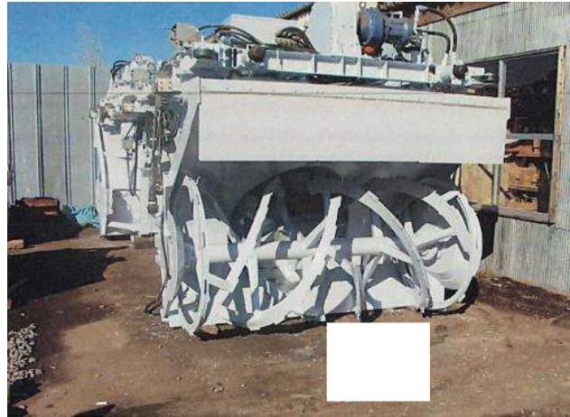
ロータリ―補修塗装完了状況④
