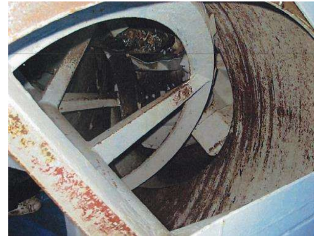
ロータリーオーガー・ブローア部塗装前状況①
