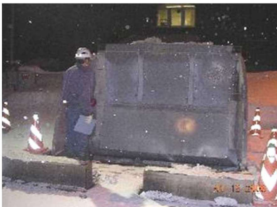
投雪蓋全開運転(内部点検)
