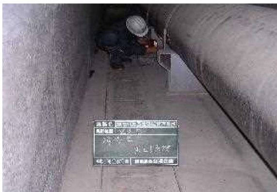
【送水管点検状況】
