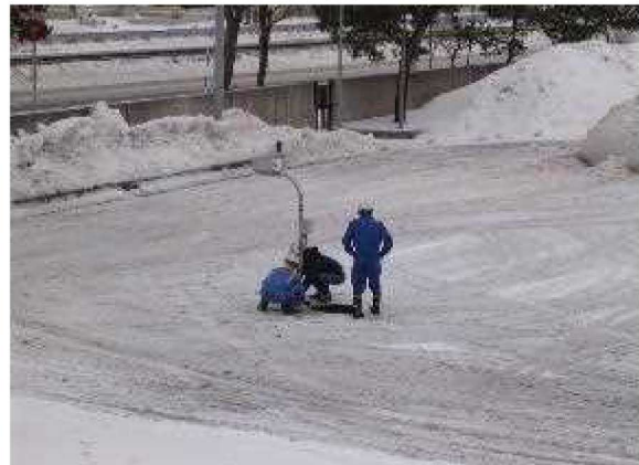
RFID認証装置設置
