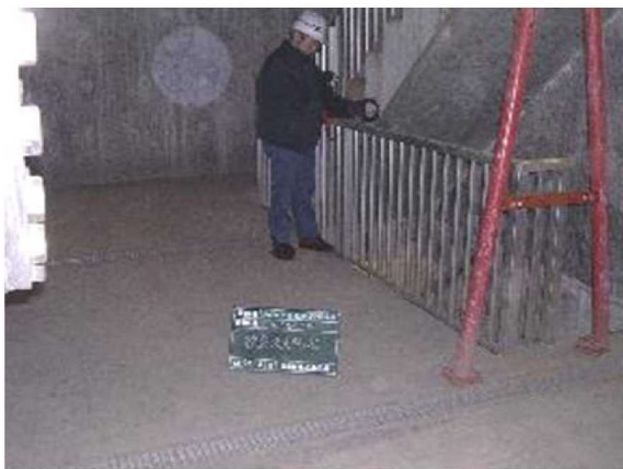
酸素濃度等測定(⑤No.3MH(下部))
