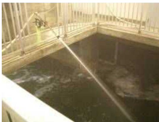
放水銃試運転
