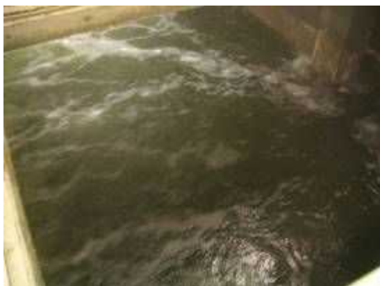
プロアポンプ試運転
