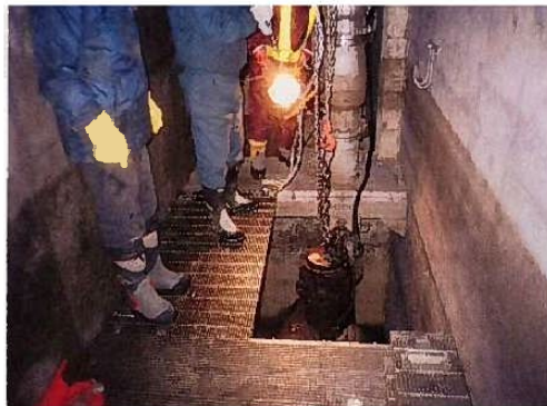
噴射ポンプ設置
