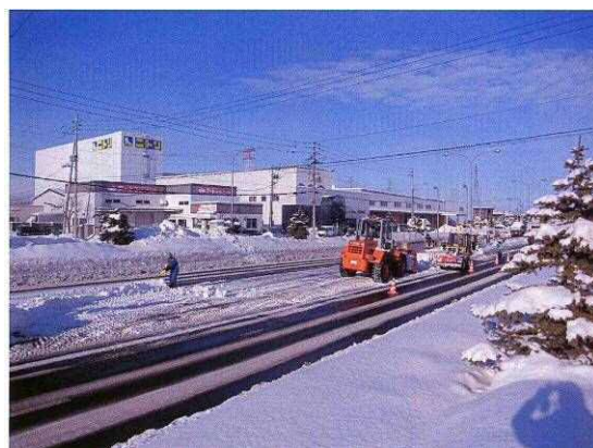
(2) 投雪ハッチを開け、ヤード部分の雪をショベルで投雪する。
