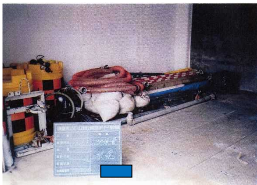
搬出入シャッター室内
