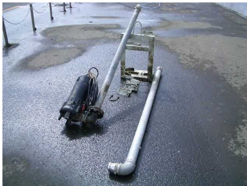
引上げ後の水中ポンプ
