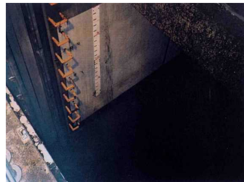
放水ポンプ設置前
