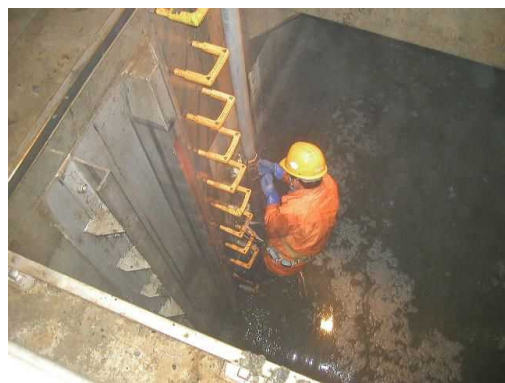
上部配管取外し
