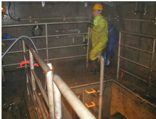
撤去前、落下防止策取外し
