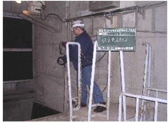
酸素濃度等測定(②No.2ロータリー室)
