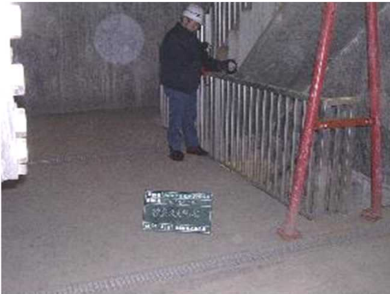
酸素濃度等測定(⑤No.3MH(下部))
