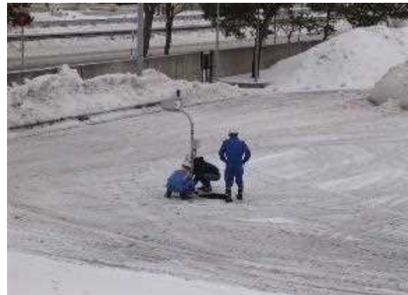
RFID認証装置設置
