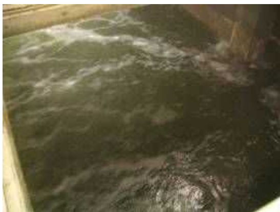
ブロアポンプ試運転
