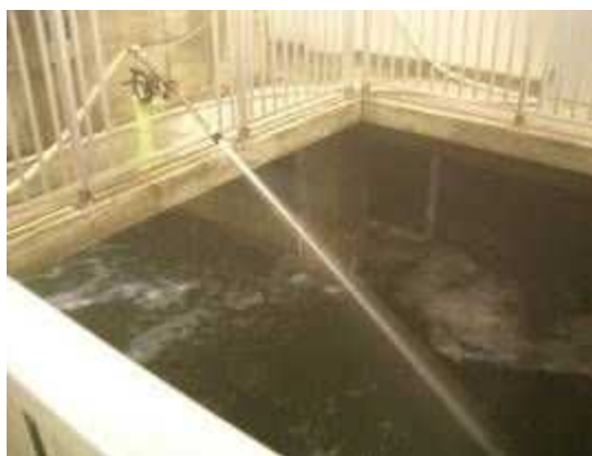
放水銃試運転
