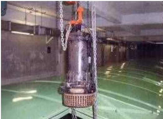
水中ポンプ 清掃後状況
