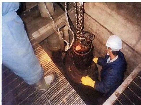
噴射ポンプ設置
