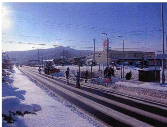
(1) ミニショベルを使いヤード部除雪実施
