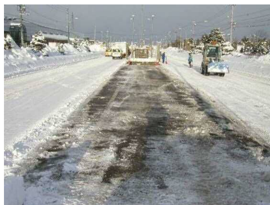
(4) ヤード部分の雪を全て投入後、ハッチを閉める。
