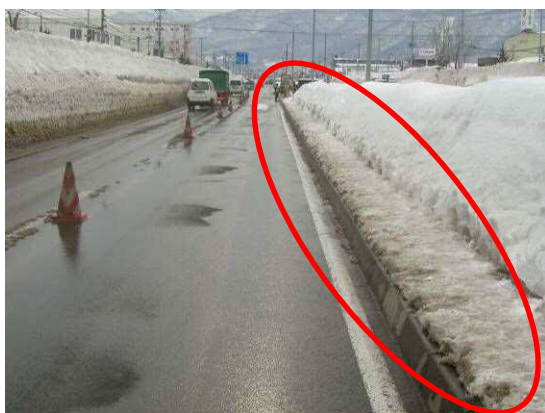
(3) 中央分離帯上の作業員通路部分の除雪も開始前除雪時に行う。
