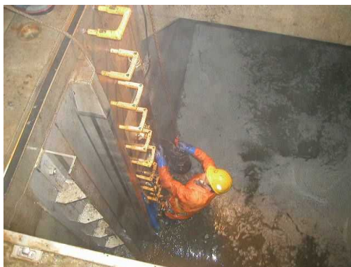
水中ポンプ撤去
