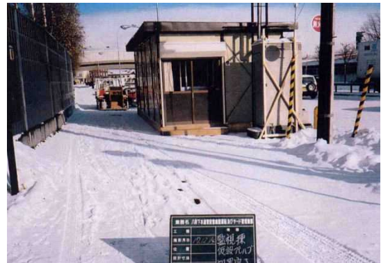
仮設ハウス設置状況
