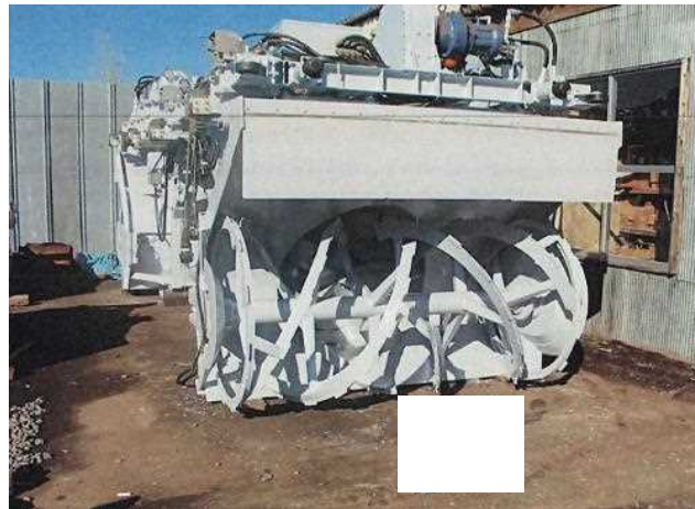
ロータリー補修塗装完了状況④
