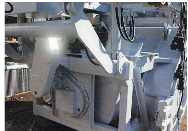
ロータリー補修塗装完了状況⑤
