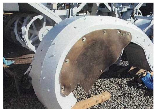
ロータリー補修塗装完了状況⑧
