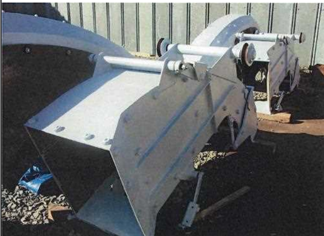
ロータリー補修塗装完了状況⑥
