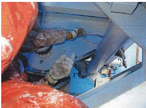
ロータリー本体部塗装作業状況
