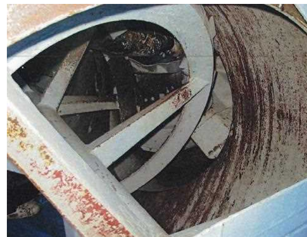
ロータリーオーガー・ブロー部塗装前状況①
