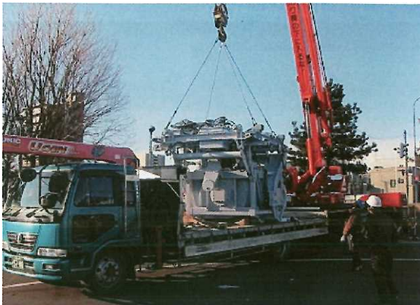
ロータリー搬入状況①
