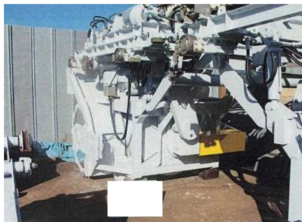
ロータリー補修塗装完了状況①
