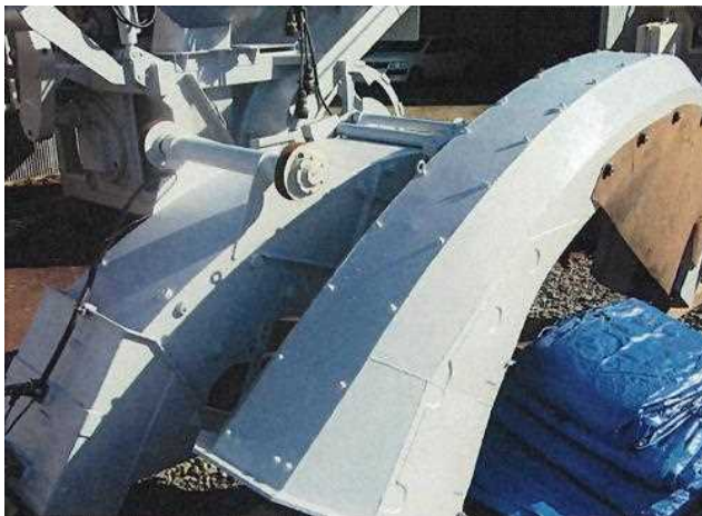
ロータリー補修塗装完了状況⑦
