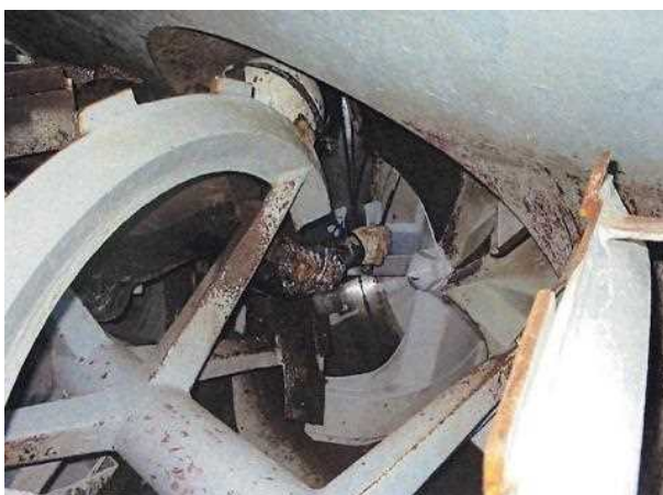
ロータリーオーガー・ブロー部塗装前状況②
