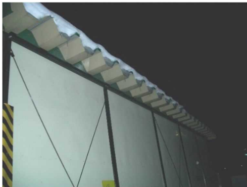
ハウス屋根部状況
