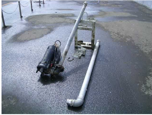
引上げ後の水中ポンプ
