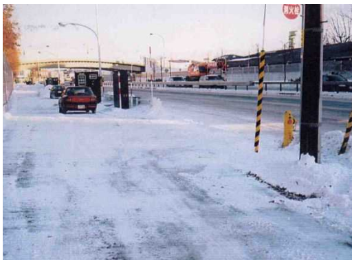
仮設ハウス設置前
