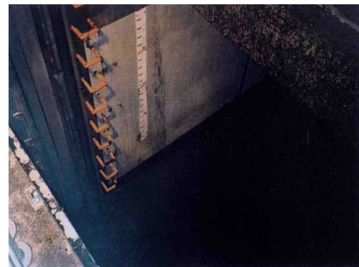
放水ポンプ設置前
