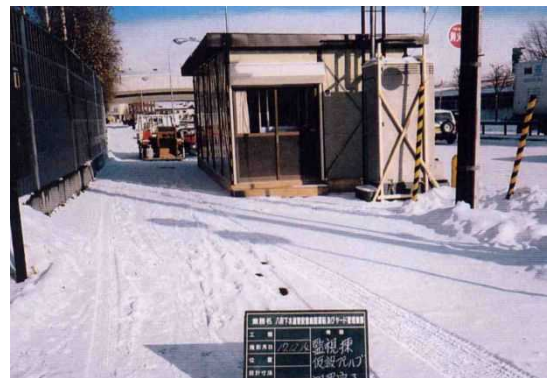
仮設ハウス設置状況
