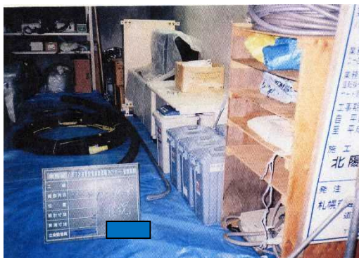
旧熱交換器室
