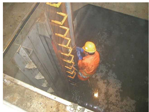
上部配管取外し
