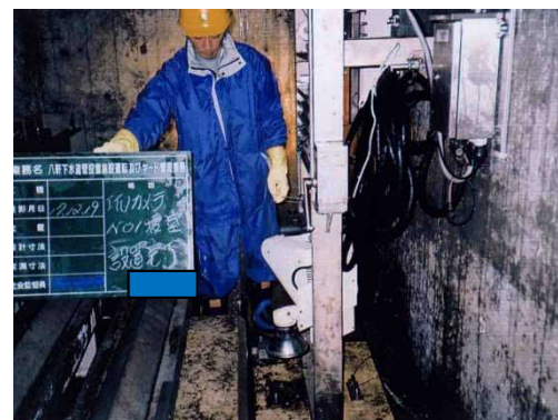
No.1 堰室カメラ設置後
