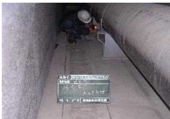
【送水管点検状況】
