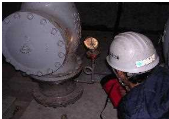
【送水ポンプ点検状況】
