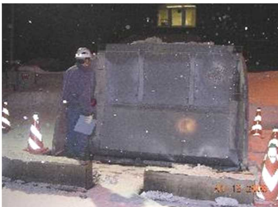
投雪蓋全開運転(内部点検)
