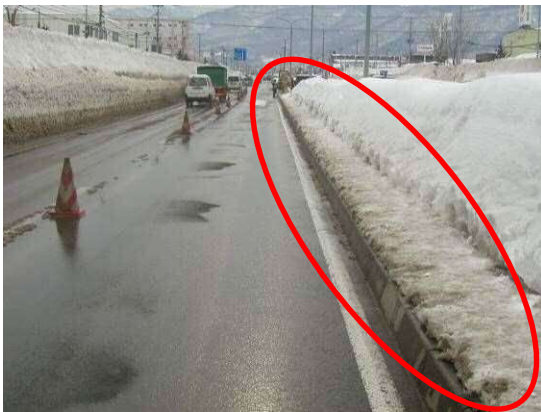
(3) 中央分離帯上の作業員通路部分の除雪も開始前除雪時に行う。
