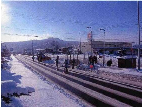
(1) ミニショベルを使いヤード部除雪実施
