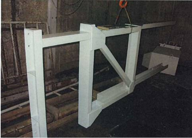
ロータリー補修塗装完了状況⑨
