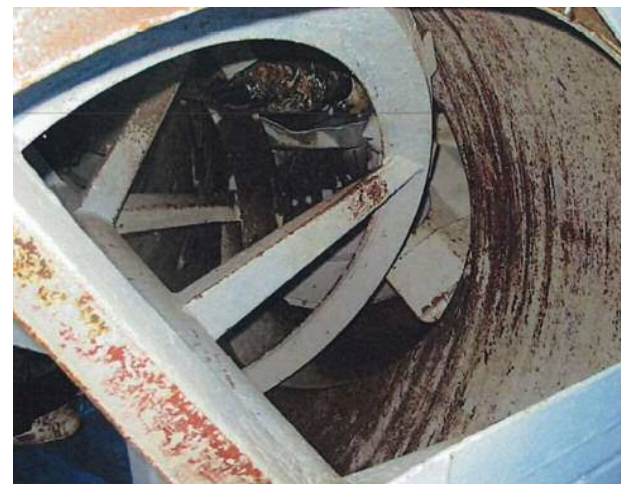
ロータリーオーガー・ブローア部塗装前状況①
