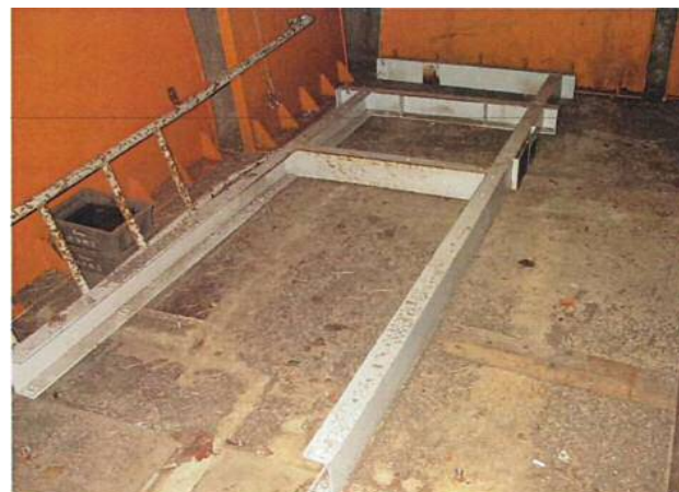
ロータリー走行装置カバーフレーム塗装前状況
