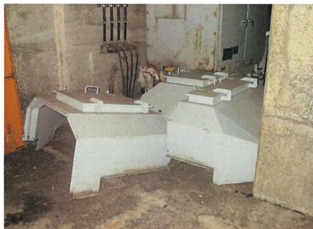
ロータリー走行装置カバー部塗装前状況
