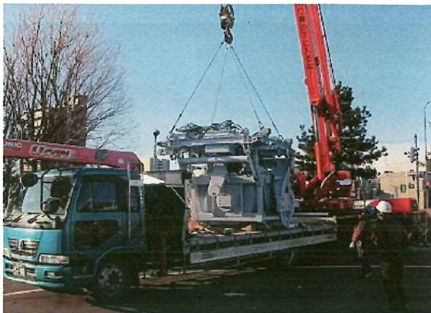
ロータリー搬入状況①
