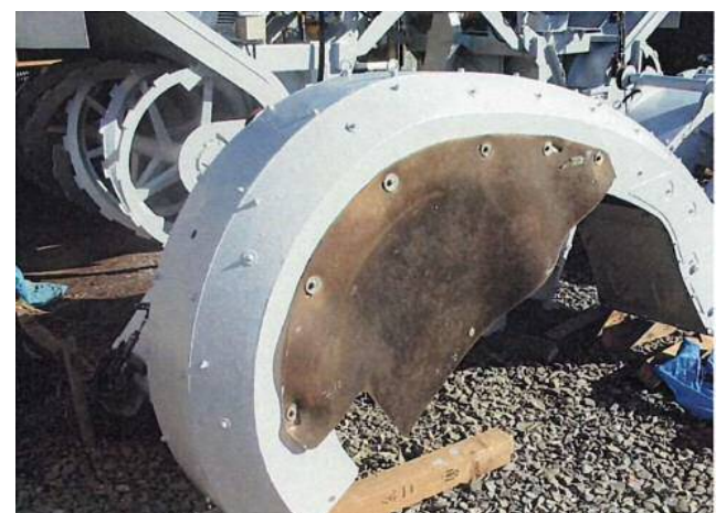
ロータリー補修塗装完了状況⑧
