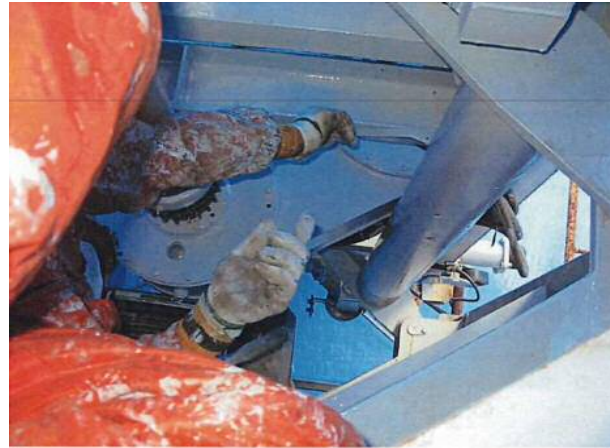
ロータリー本体部塗装作業状況
