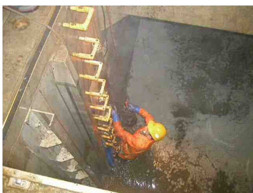
水中ポンプ撤去
