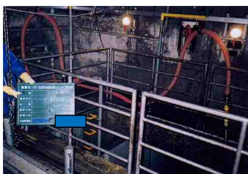
ホース設置状況
