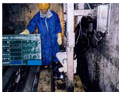
No.1 堰室カメラ設置後
