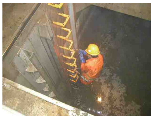
上部配管取外し
