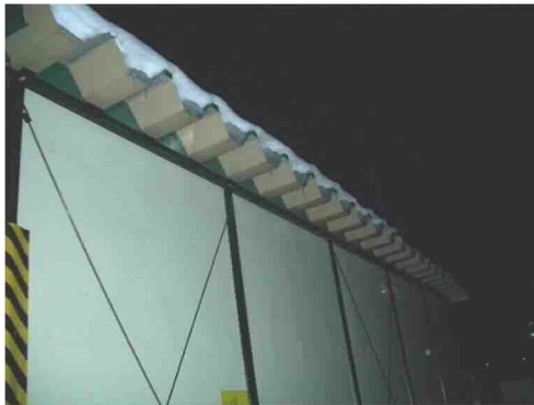
ハウス屋根部状況
