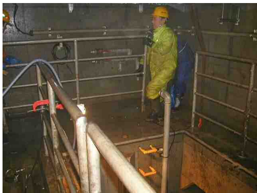
撤去前、落下防止策取外し
