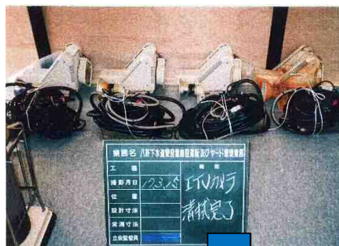
カメラ撤去・清掃後
