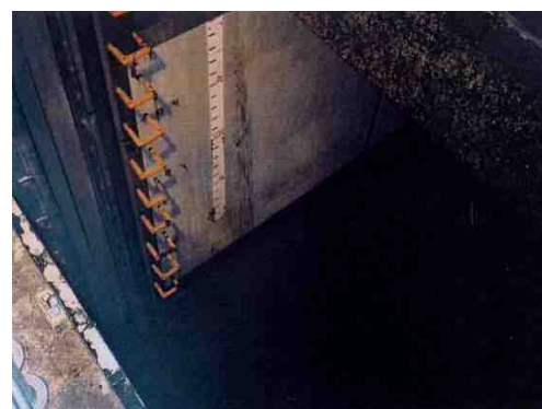
放水ポンプ設置前
