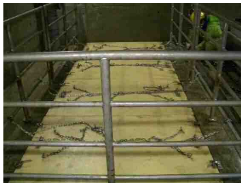
堰上げ後、転落防止蓋
