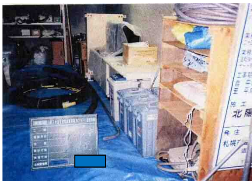
旧熱交換器室
