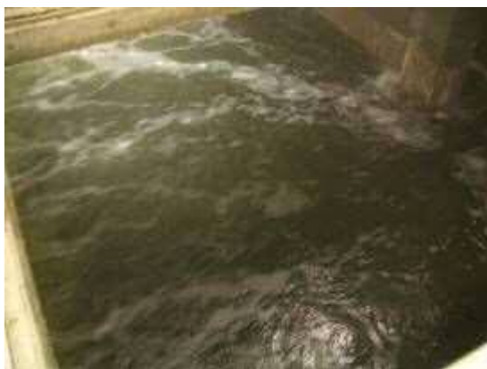
ブロアポンプ試運転
