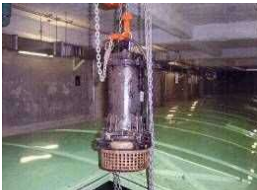
水中ポンプ 清掃後状況
