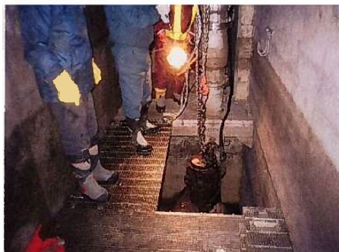
噴射ポンプ設置
