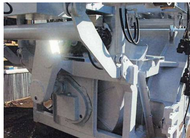
ロータリー補修塗装完了状況⑤
