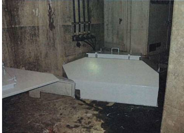
ロータリー補修塗装完了状況⑩
