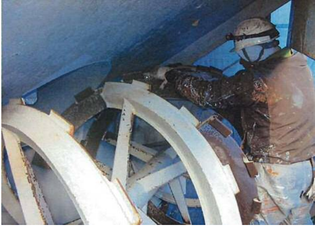
ロータリーオーガ一部塗装作業状況
