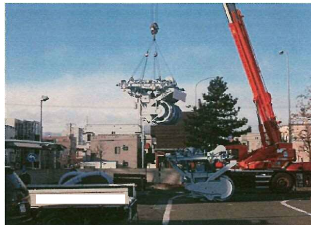
ロータリー搬入状況②
