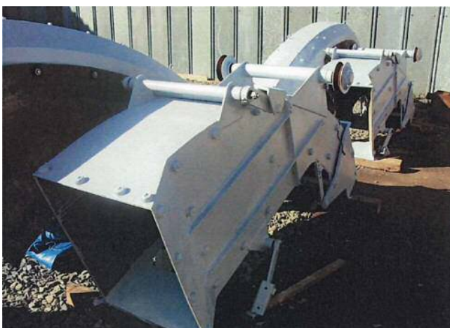
ロータリー補修塗装完了状況⑥
