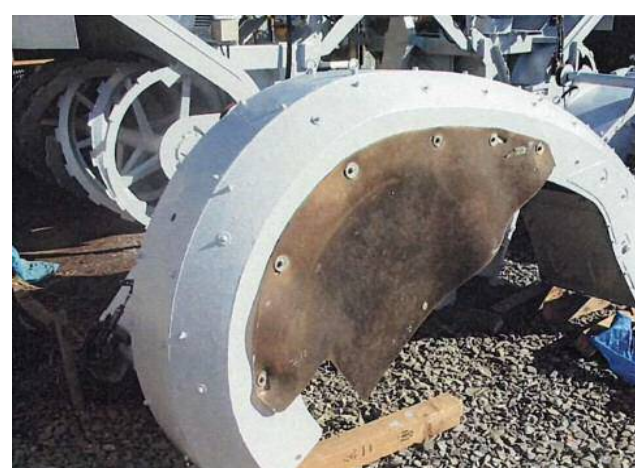
ロータリー補修塗装完了状況⑧
