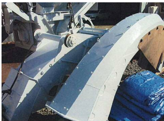
ロータリー補修塗装完了状況⑦
