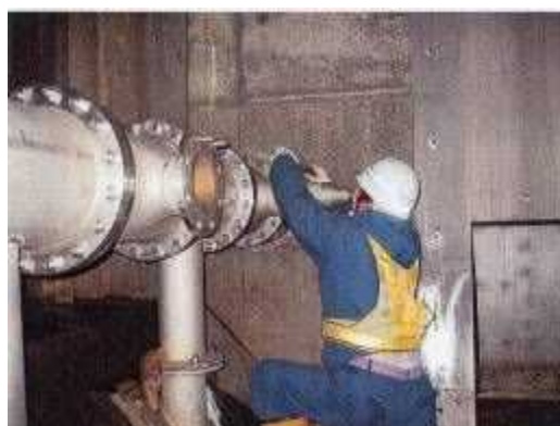
噴射ノズル設置
