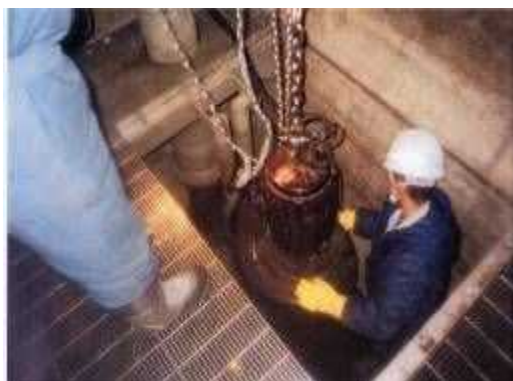
噴射ポンプ設置
