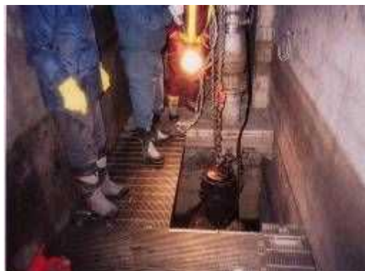
噴射ポンプ設置
