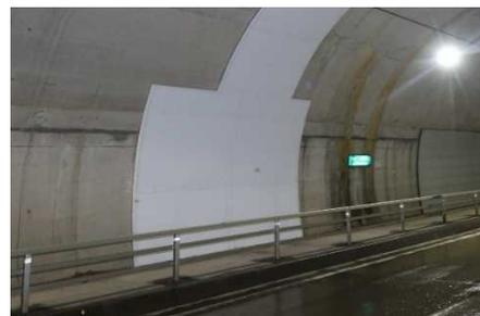
写真2.6 (対策後) 導水樋工
