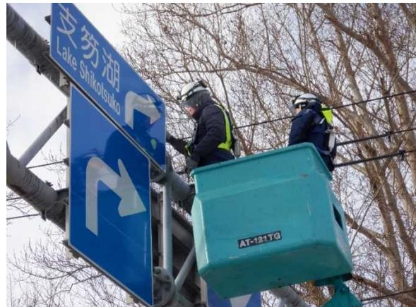
写真 2.1 高所作業車による近接目視点検
