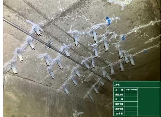
写真 2.6 ひび割れ注入工（補修中）
