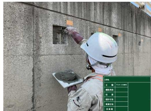
写真 2.4 断面修復工（補修中）
