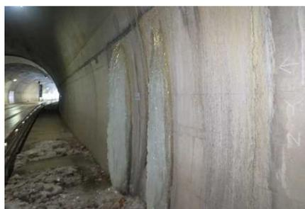
写真2.5 (対策前) 漏水による氷柱
