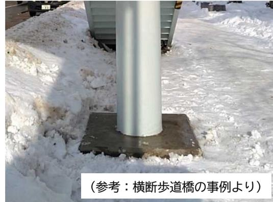
写真2. 4 腐食（補修前）
