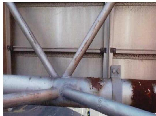
写真2. 2 亀裂・変形（補修前）
