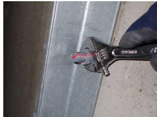
写真2. 6 ゆるみ・脱落（補修前）
