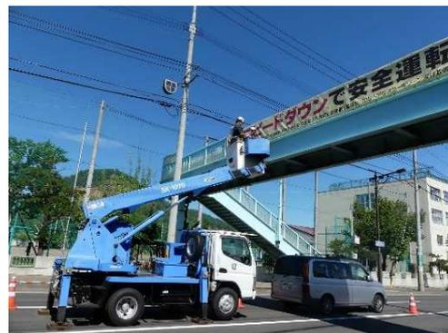
写真 2.5 高所作業車による近接目視点検
