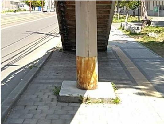
写真2. 3 亀裂・変形（補修後）
