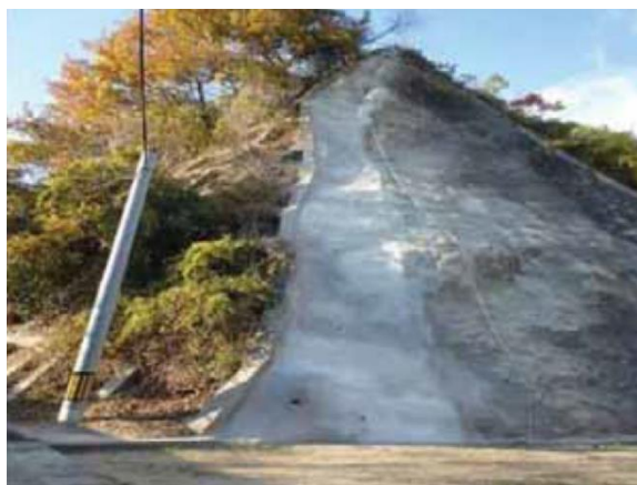
<対策実施後：損傷部を撤去後、再吹付>
