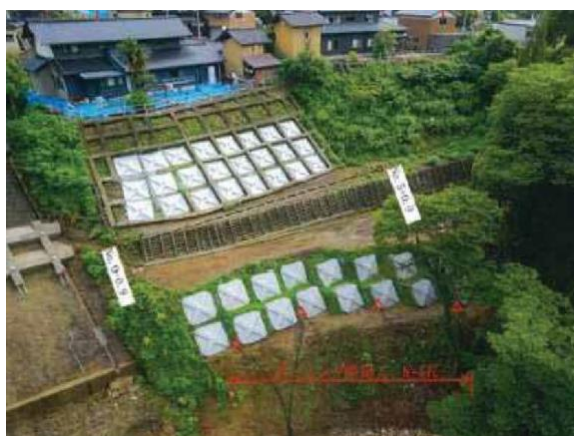
<対策実施後：アンカー工増設>
