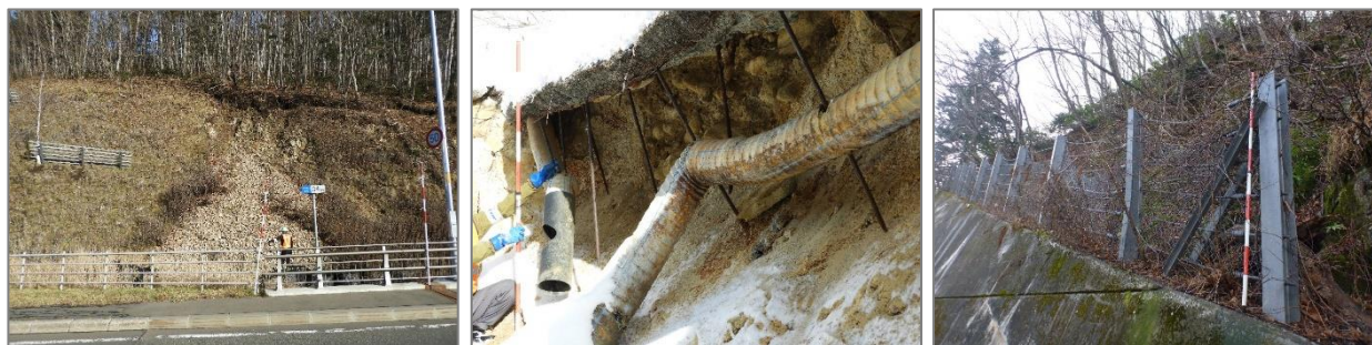
写真 3.1 近接目視点検状況
