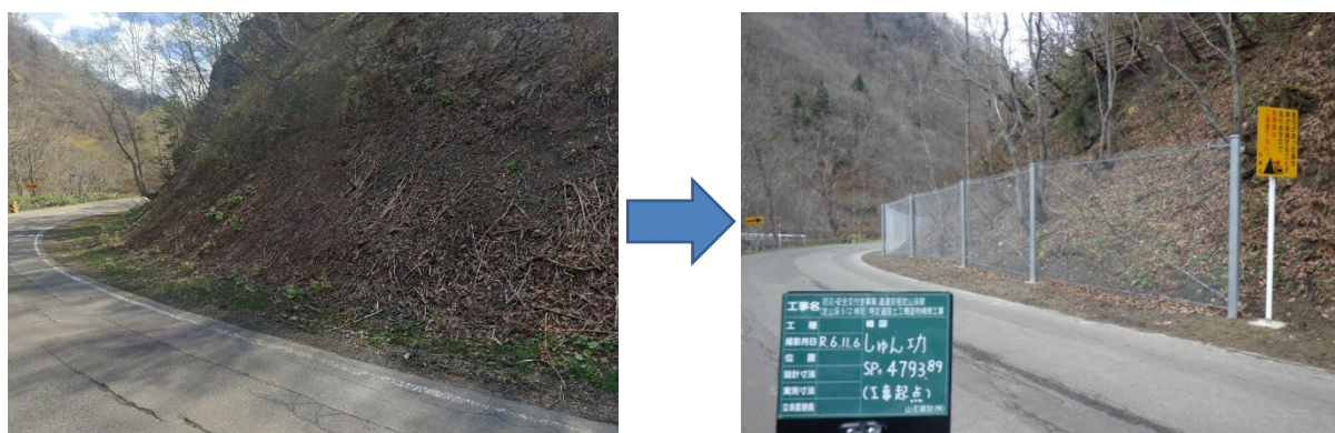
写真2.2 R6 京極定山溪線 落石防護柵
