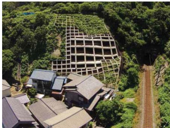
<対策実施後：空隙部分の撤去・再設置>
