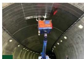
補修工法における新技術の活用では、うき・はく離が生じても直ちに覆工コンクリート片がはく落(落下)しないための補修技術を検討します。施工後も覆工面の確認が可能で、極寒冷地における耐久性があり、施工性、経済性に優れた工法を適用していくことによって、トンネルの長寿命化とライフサイクルコストの縮減を目指していきます。
