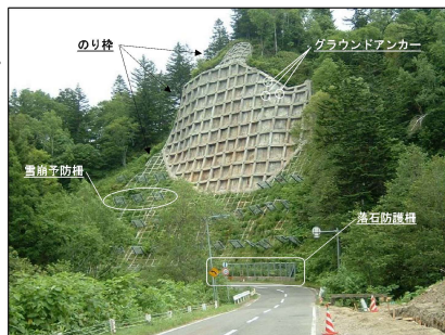
<特定道路土工構造物の構成>
