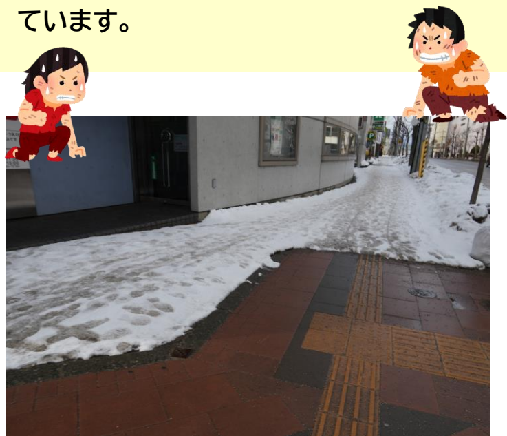
▲幸いなコトニ、ロードヒーティングのある所とない所の境目が見れました。 効果がはっきりと出ています。
