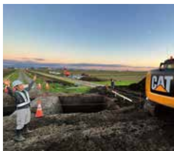
現場での実証実験を実施。 試行錯誤を繰り返しながら開発が進められた
