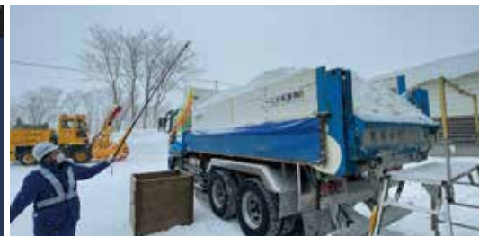
安全性も向上。従来はダンプの縁に立ちテープを用いて積載量を計測していた。
