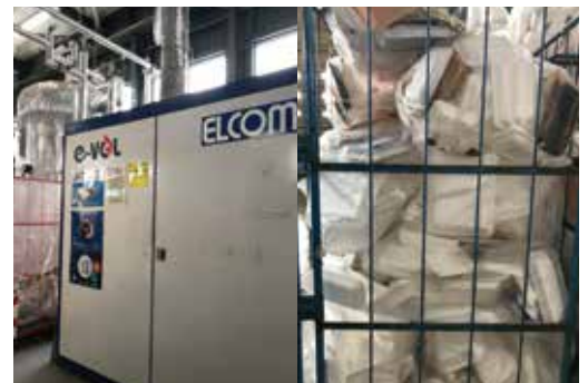
札幌市のスーパーのエコセンターでは、使用済フードトレイなどから創エネルギー。暖房と給湯の熱源となる樹脂燃料ボイラ「イーヴォル」
