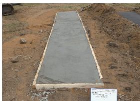
縦型平板地中熱交換器 設置後
