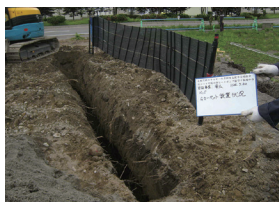
縦型平板地中熱交換器 設置前
