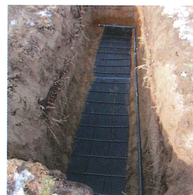
水平型地中熱交換器設置状況
