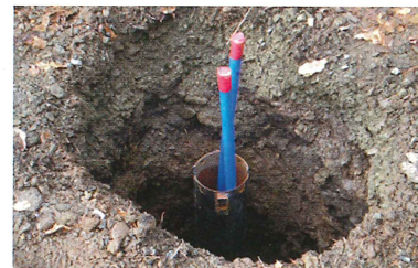
9m 以上埋設できた熱交換器の中間パイプとポリエチレン管
