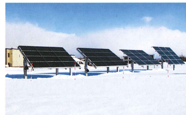
滑雪性能実証施設
