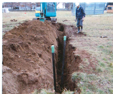
縦型地中熱交換器設置状況
