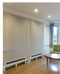
試作機設置状況
