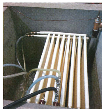
プラスチック製熱交換器の槽への設置
