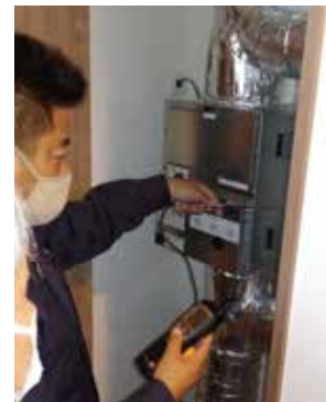
エコブレス®は日常的なメンテナンスがしやすいように設置。費用もかけずに換気性能を維持できる
