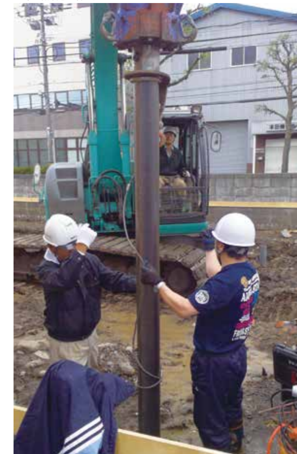
地中に鋼管杭を打ち込む
