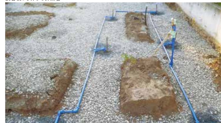
鋼管杭から伸びる採熱管
