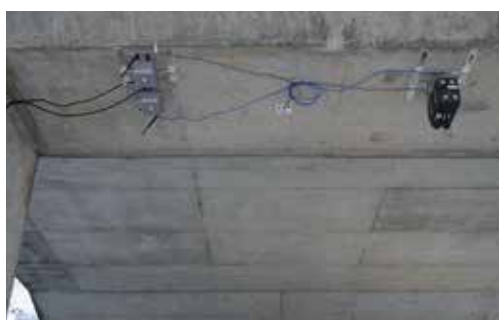
▲TAMカメラ(黒い筐体)とIoTルータ(アンテナが見えるグレーの筐体)
