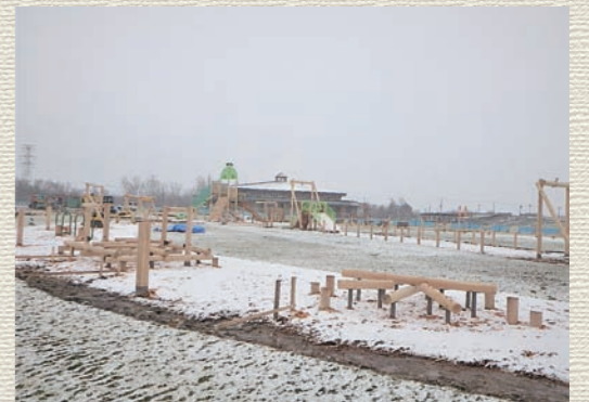
現在の工事状況
