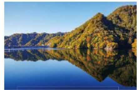
⑨ 定山溪ダム
